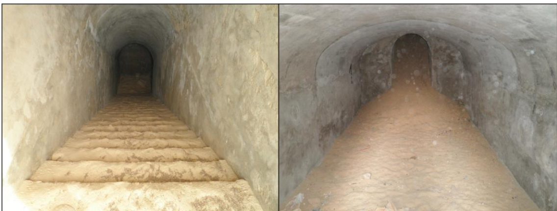
Figura 14. A la izquierda, acceso a una instalación subterránea del interior del recinto. A la derecha, depósito subterráneo anexo al emplazamiento del cañón al sur de la torre sur (2013)
