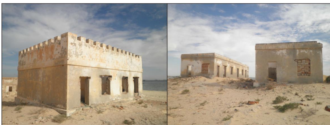
Figura 17. A la izquierda, la única edificación almenada, desde el sur. A la derecha, construcciones destinadas a alojamiento, desde el suroeste (2013)
