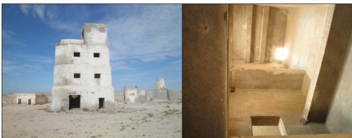
Figura 16. Vista de la torre sur, desde el sureste. A la derecha, detalle del espacio interior de la torre (2013)
