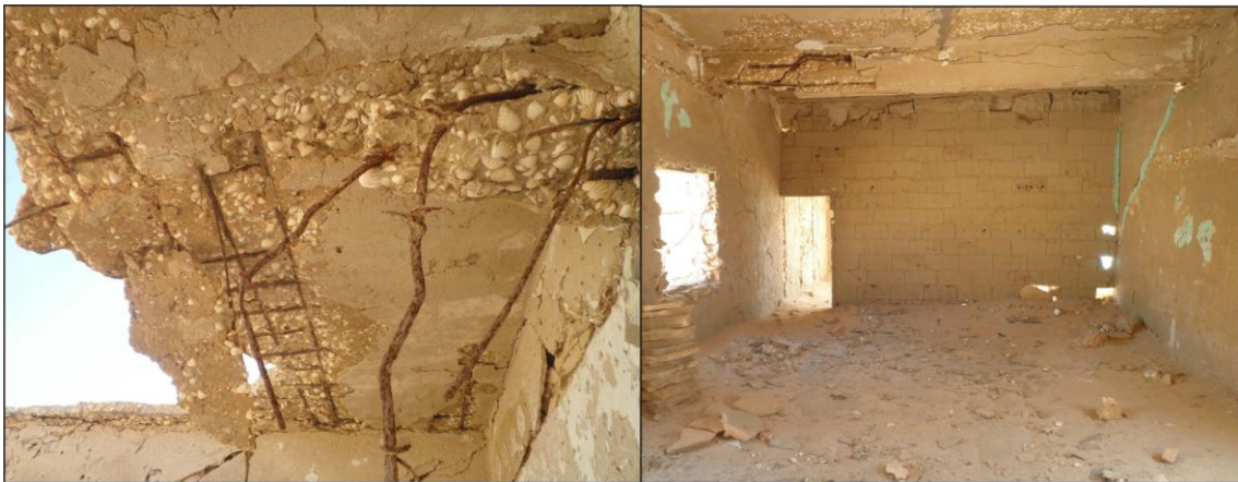
Figura 11. Detalle actual de la losa de la cubierta del lado noreste y de una de las vigas del interior del lado suroeste (2013)
