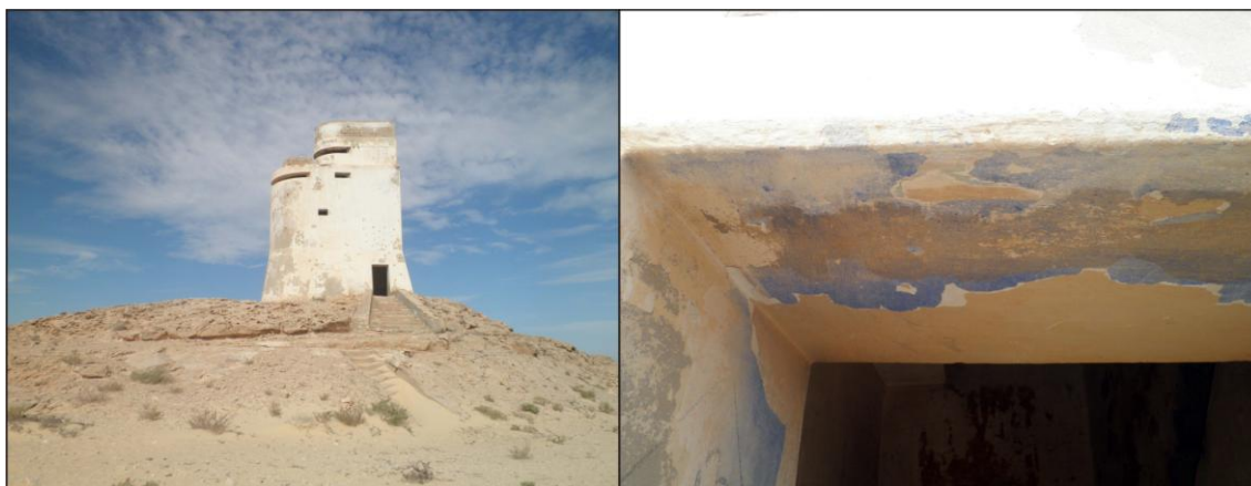
Figura 15. Vista de la torre norte, desde el sureste. A la derecha, detalle de la huella de pintura azul en la entrada de la torre (2013)
