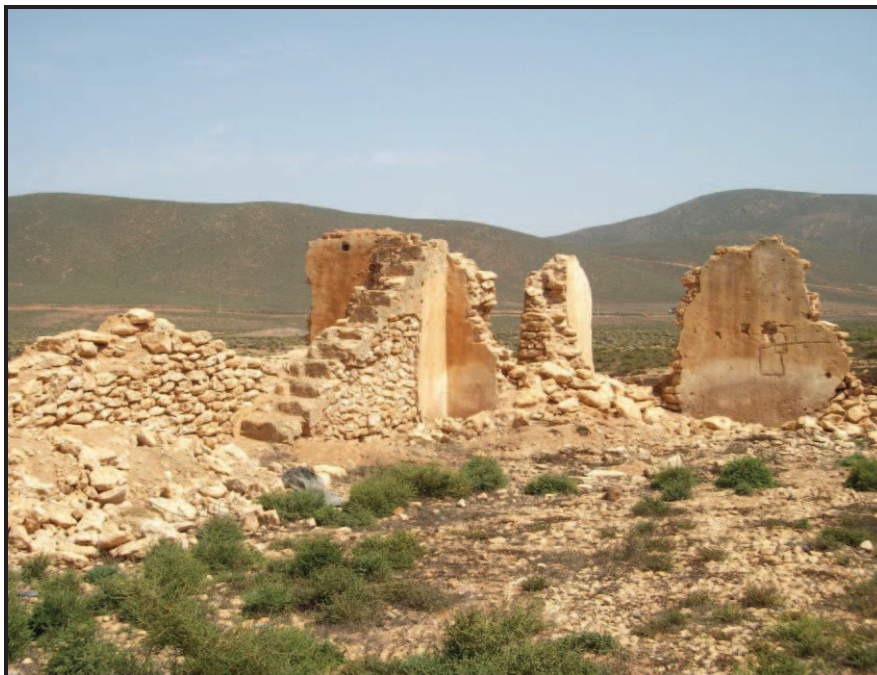
Figura 7. Vista de las estructuras derruidas del ángulo interior sureste, desde el noroeste.
