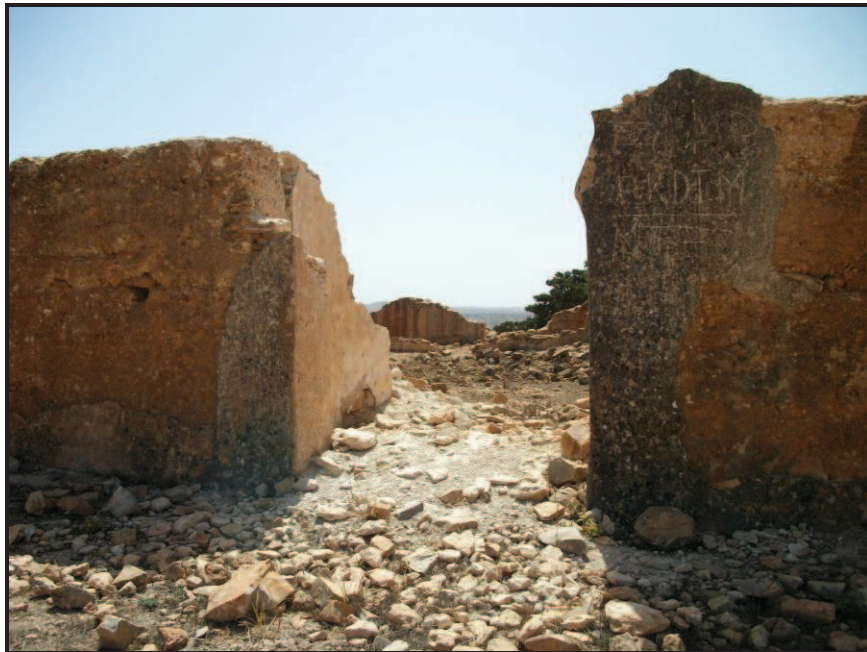
Figura 12. Detalle de los restos del arco de herradura de la entrada, desde el oeste.
