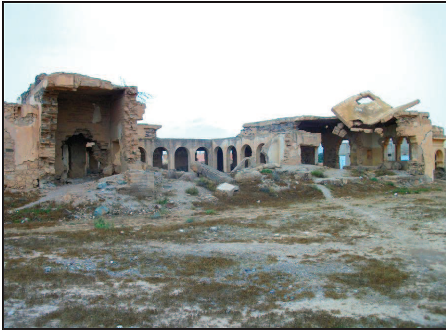
Figura 15. Vista de las ruinas de la edificación principal, desde el este. Se observa, en el centro, el patio interior porticado.
