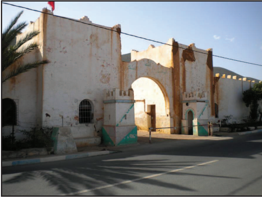
Figura 5. Aspecto actual de la entrada del antiguo cuartel de La Legión, desde el norte.
