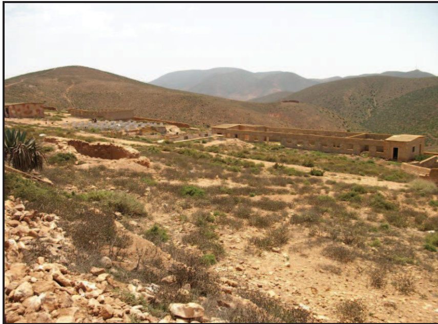
Figura 9. Precario estado actual de las instalaciones del Coraima, desde el noreste.
