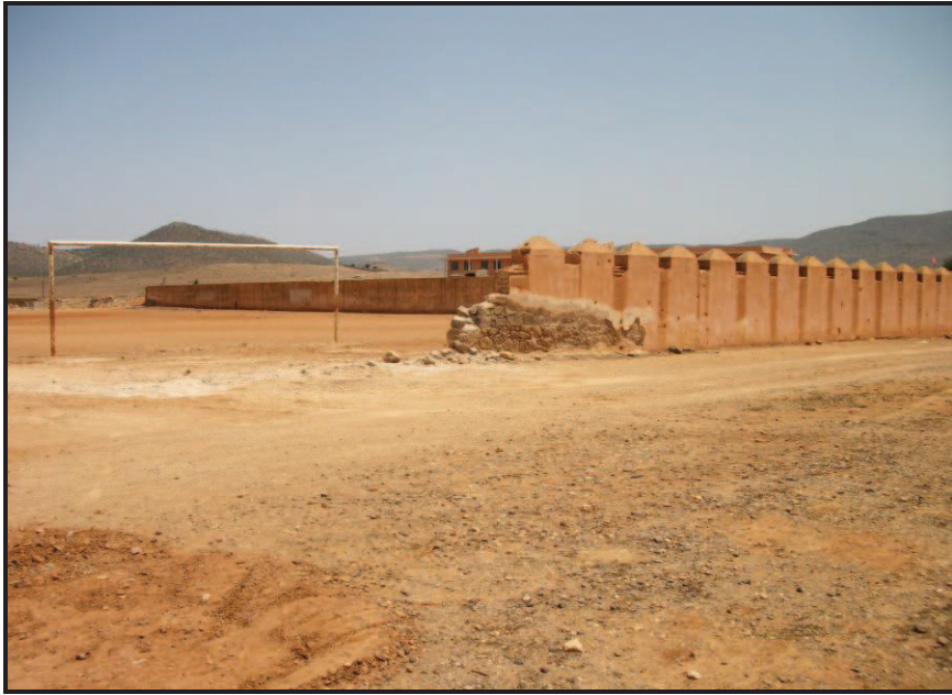
Figura 11. Muro perimetral del cuartel de Tiradores en la actualidad, desde el suroeste.
