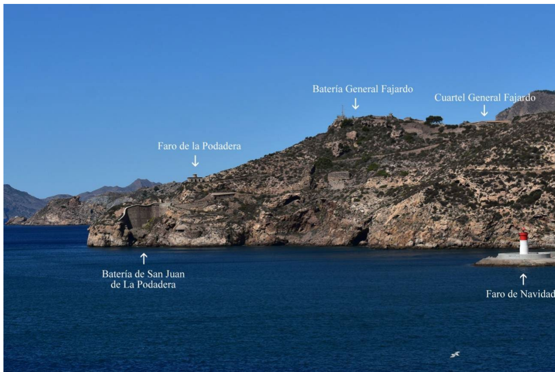
Imagen 1. Faro de la Podadera y edificaciones militares abandonadas de su entorno. Fotografía de los autores.
