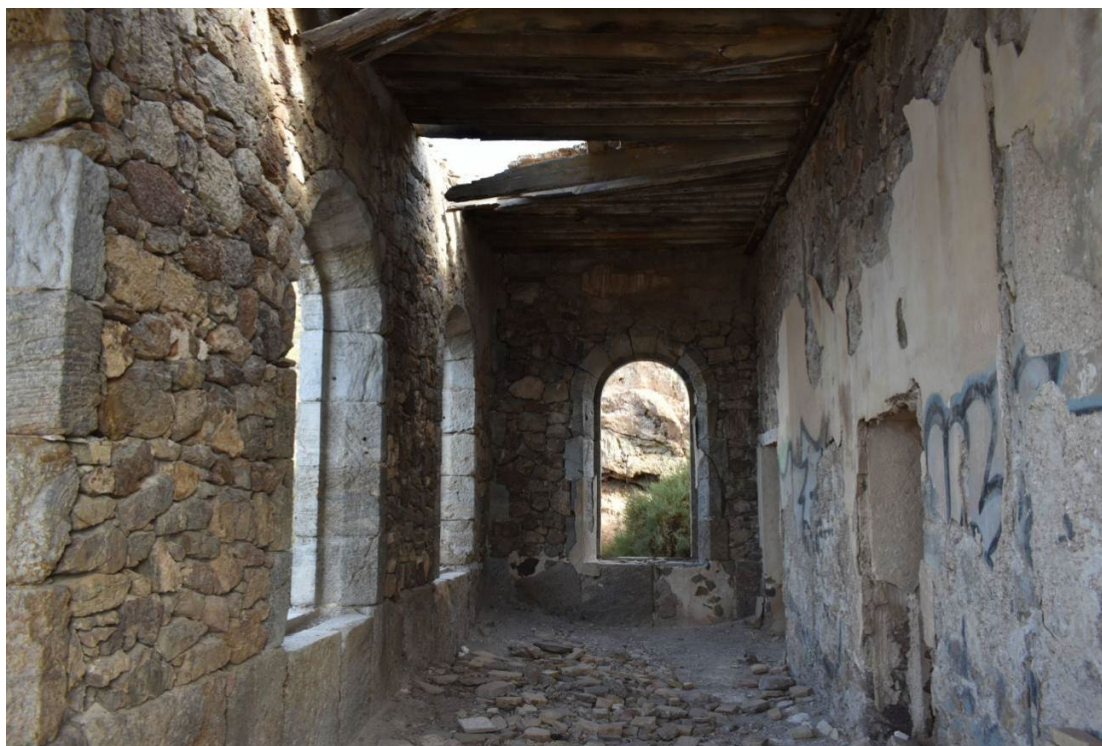
Imagen 6. Dependencias traseras del Faro de la Podadera. Nótese los escasos enlucidos que perviven en sus muros. Fotografía de los autores.
