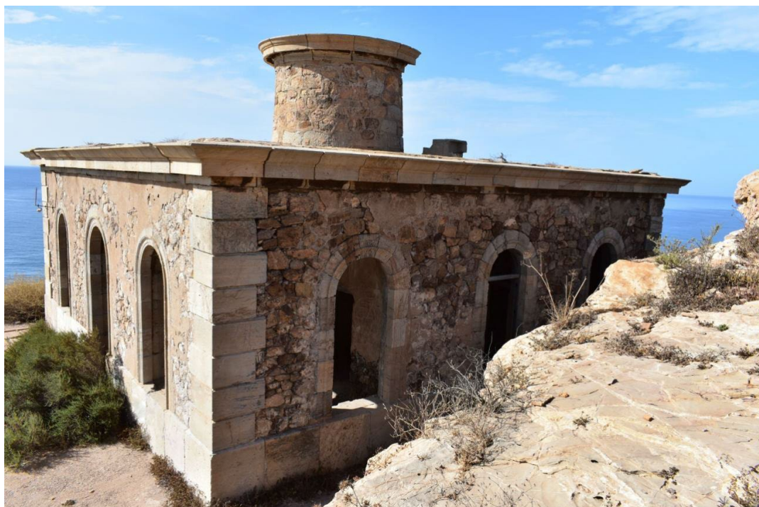
Imagen 2. Fachada principal (este) y fachada norte del faro (Cartagena). Fotografía de los autores.
